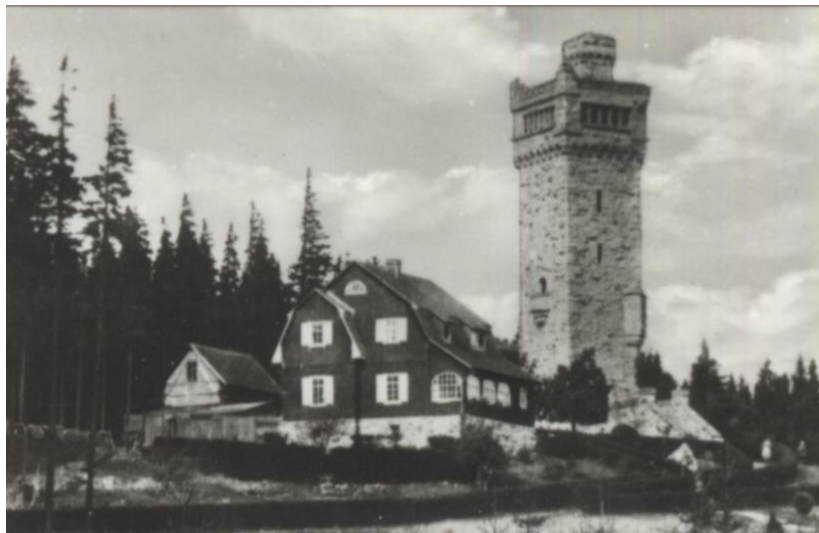
Abb. 26 Der Turm der Hohen Warte mit Gasthaus. Gerade bei der Errichtung von Aussichtstürmen auf diesem Bergsporn zeigt sich anschaulich, daß nur massives Mauerwerk mit Festungscharakter den extremen Witterungseinflüssen im Thüringer Wald auf Dauer standhalten können, Die leichter gebauten zwei Vorgängertürme der Hohen Warte schafften das nicht (Ansichtskarte 1976)
