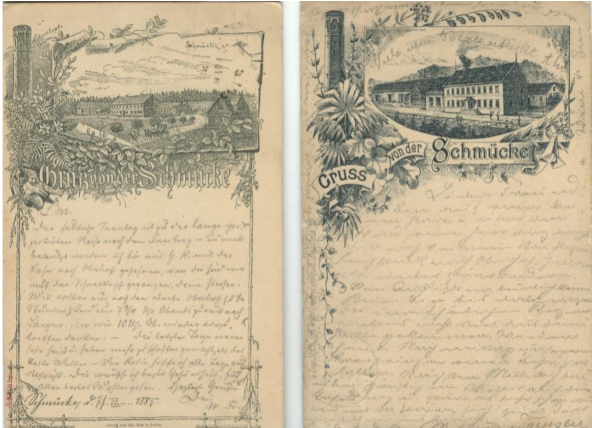
Abb. 24 Die Gebäudegruppe der Schmücke auf zwei sehr frühen Ansichtskarten (um 1880) in Kombination mit dem Schneekopf-Turm (links oben). Postableitung über Gehlberg-Ort bzw. Gehlberg-Bahnhof direkt auf die Bahnpost Neudietendorf-Ritschenhausen.
